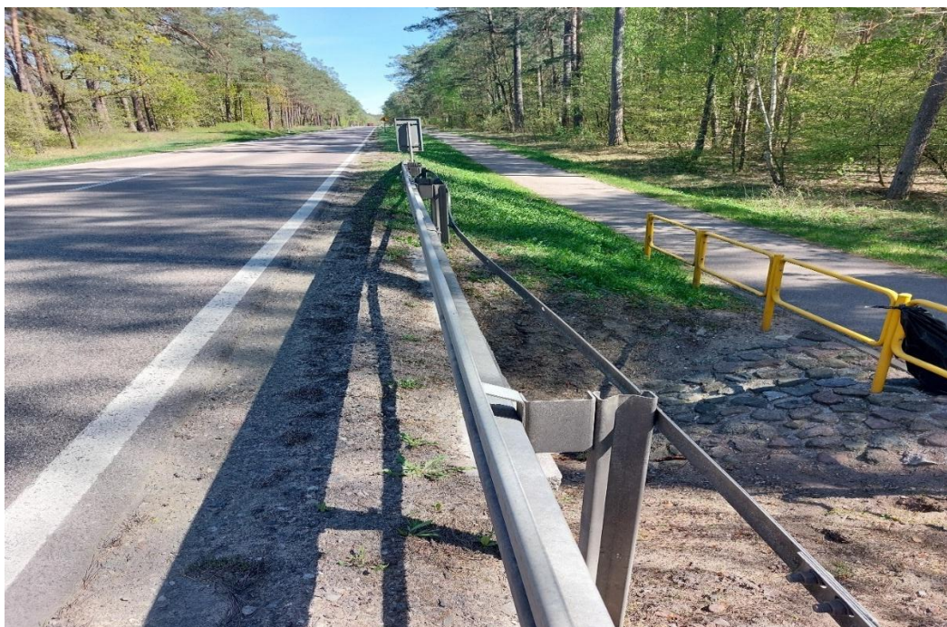
Fot. 6 Widok na barierę strona prawa– stan na dzień 25.04.2026 r.
