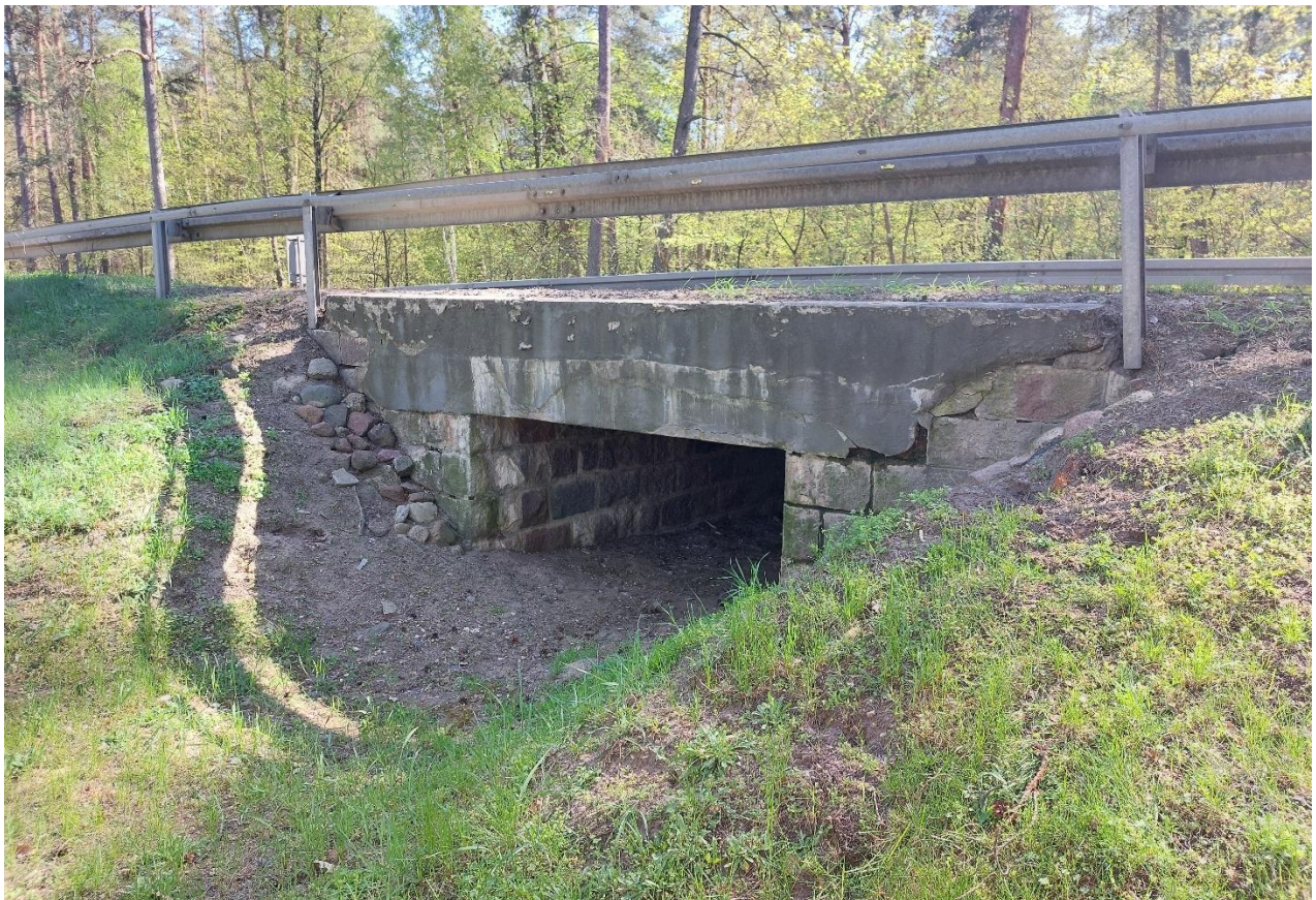
Fot. 2 Widok z boku strona lewa – stan na dzień 25.04.2026 r.
