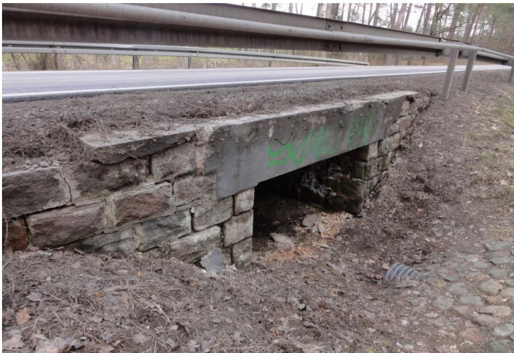
Fot. 4 Widok na barierę strona prawa – stan na dzień 09.04.2026 r.
