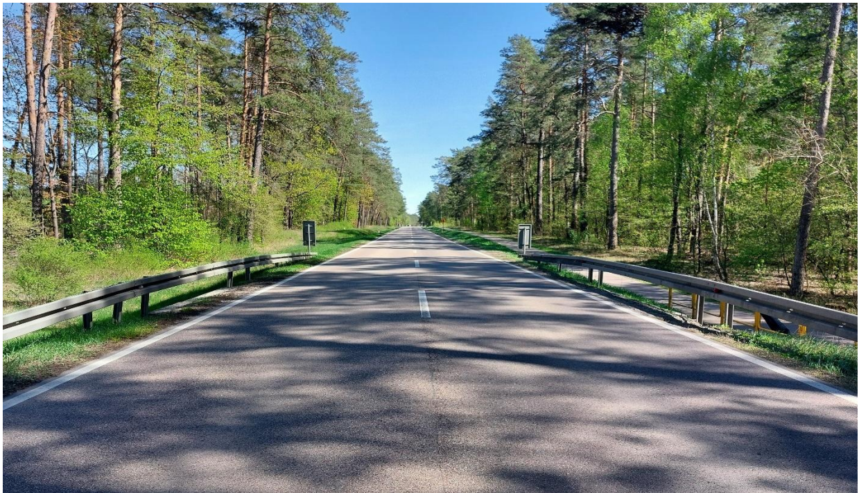
Fot. 1 Widok ogólny nawierzchni jezdni nad przepustem od strony m. Augustów - stan na dzień 29.04.2026 r.
