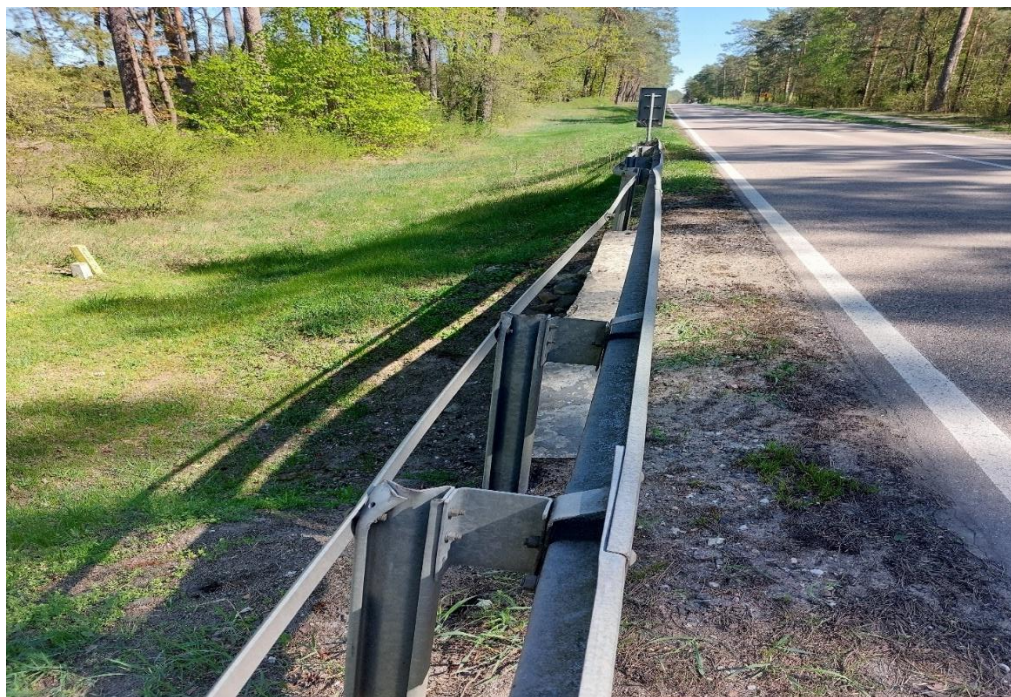
Fot. 5 Widok na barierę strona lewa – stan na dzień 25.04.2026 r.
